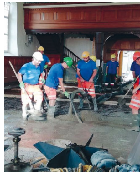
Der Boden im Schiff wird betoniert, August 2021 / Bild: Ruedi Eggenberger
