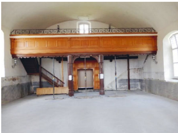
Der Boden ist betoniert, die Seitenverkleidungen entfernt, September 2021 / Bild: Jakob Tinner
