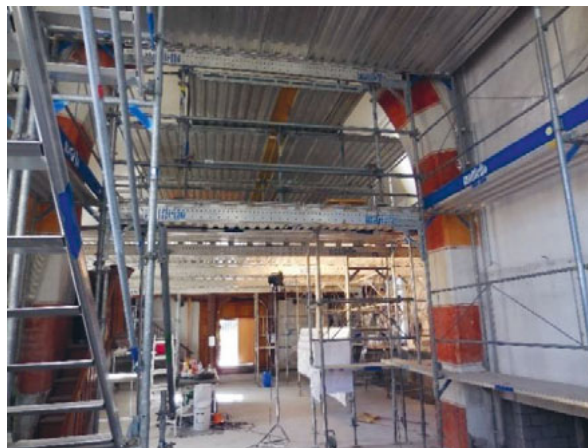
Decke und Seitenwände wurden eingerüstet, September 2021 / Bild: Jakob Tinner
