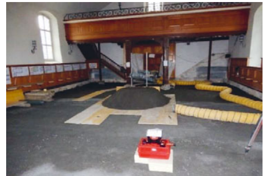
Die Trennschicht (Splitt) wird aufgetragen, Juli 2021 / Bild: Jakob Tinner
