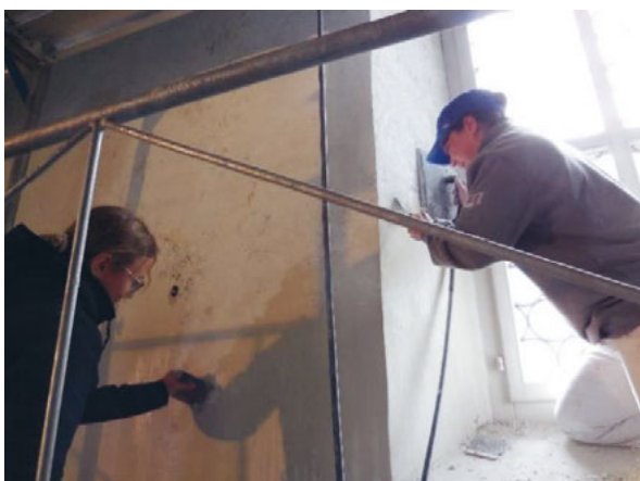
Entfernen der nicht atmungsaktiven Farbe an den Wänden des Schiffs, Oktober 2021 / Bild: Jakob Tinner
