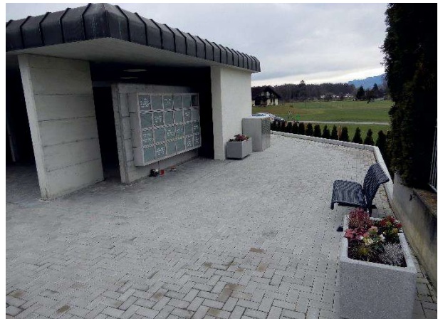
Die Umgebung der Aufbahnhalle ist nun fertig gestellt.
