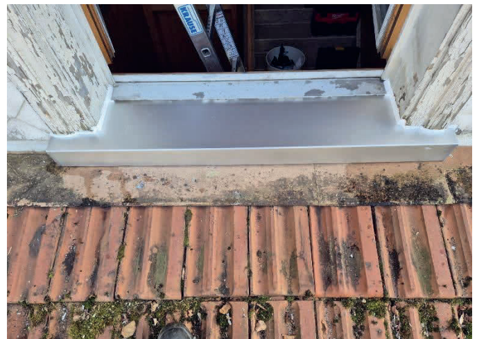
Blechverkleidung Pfarrhaus Salez. Foto: Hansueli Dütschler
