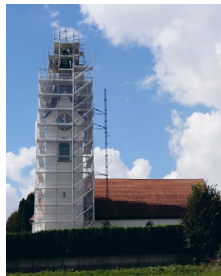
Erneuerungsarbeiten beim Kirchturm in Salez / Bild: Jakob Tinner
