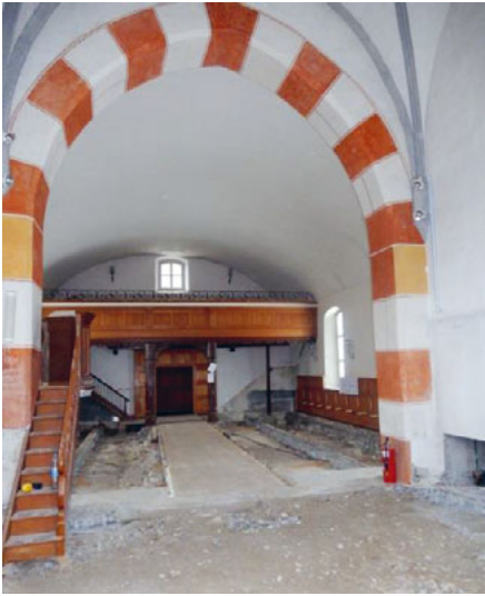
Erneuerungsarbeiten im Innern der Kirche von Sax / Bild: Jakob Tinner
